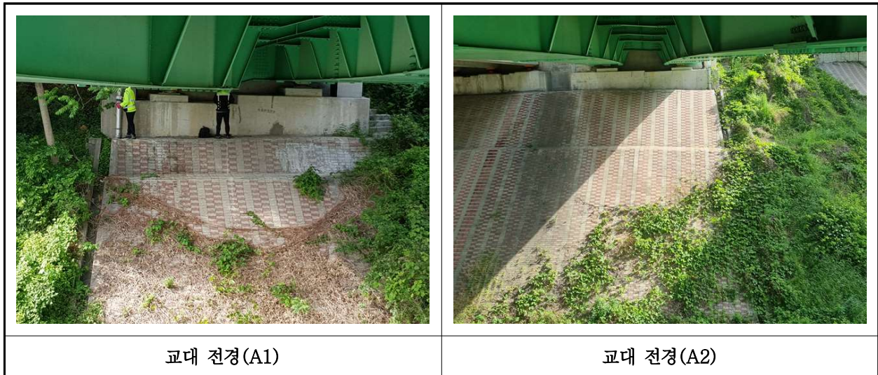
【사진 37.3.8】 교대 전경
