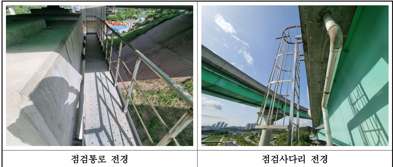
【사진 37.3.26】 교량 점검시설 전경
