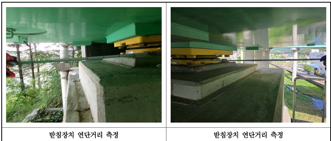
【사진 37.3.15】 교량받침장치 연단거리측정
