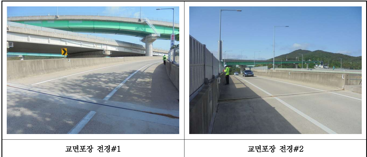
【사진 37.3.20】 교면포장 전경
