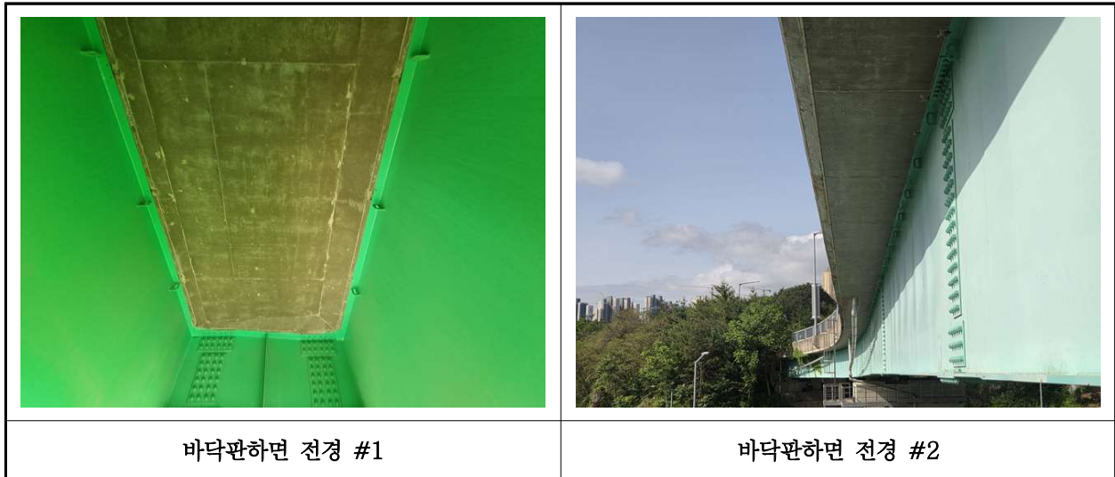
【사진 37.3.2】 바닥판하면 전경
